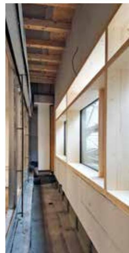
Die Rubner Holzbau GmbH Augsburg hat für Sanierungen ein raffiniertes System entwickelt: Sie baut vor die eigentliche Fassade eine neue vorgehängte in Holzrahmenbauweise mit gleichem Achsraster, ausgestattet mit einem eigenen Fundament und an den Stahlbetonstützen des Bestandes befestigt. So wird die Fassade getauscht, und die Sanierung findet dahinter statt.
