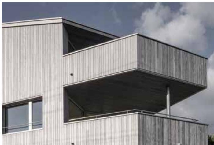
Bei einem Mehrfamilienhaus in Buchs wurde die TS3-Technologie angewandt und als Stütz-Plattenkonstruktion errichtet. Das Ergebnis kann sich sehen lassen: Dünne Geschoßdecken und schlanke Stützen gewährleisten so viel Raum wie möglich.
