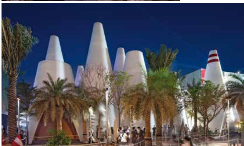
Preisgekrönt: Der Österreich-Pavillon ist inspiriert von arabischen Windtürmen und verbindet traditionelle Bautechnik mit Know-how aus Österreich. Er kommt ohne technische Kälteerzeugung aus und benötigt 70 Prozent weniger Energie als konventionell klimatisierte Gebäude in Dubai. Dafür wurde das Generalplanerteam von Querkraft Architekten mit dem renommierten „Global Architecture & Design Award 2021“ ausgezeichnet.
