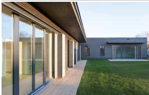
Die Außenwände des Ambulatoriums sind als vorgefertigte Holzständerwände ausgeführt.
