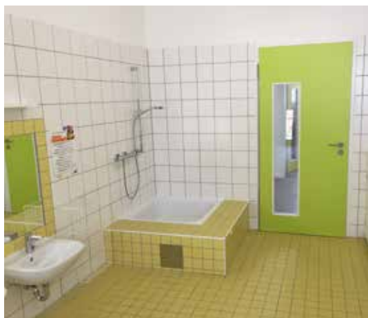
Das Sanitär-Modul wird inklusive Toilettenanlagen und Dusche fixfertig angeliefert.
