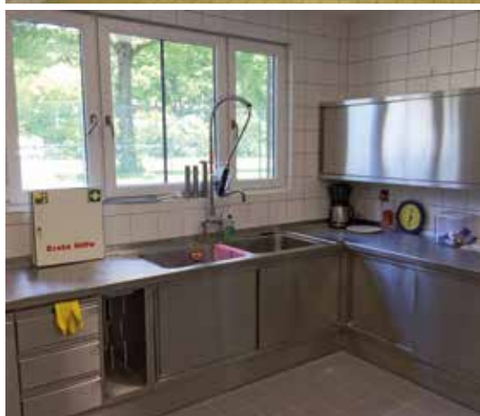
Lieferung samt Küche: Im Containergebäude wird auch noch selbst gekocht – der vorgefertigte Sanitär-container macht's möglich.
