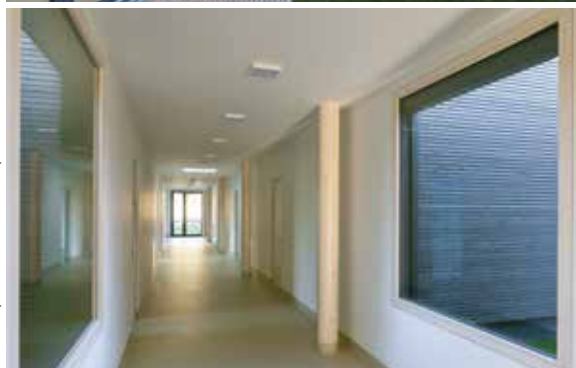
Insgesamt 40 Leimholzsäulen tragen die gesamte Dach- bzw. Deckenlast.
