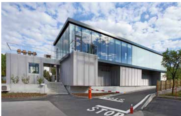
Multifunktionsgebäude aus vorgefertigten Raummodulen am Firmenstandort von KOMA Space in Vizovice in Tschechien.
