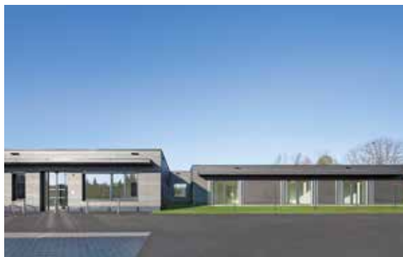
Das neue VKKJ-Ambulatorium in Mistelbach wurde vollständig in Leichtbauweise errichtet.
