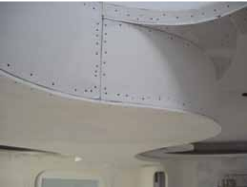
Baustellenfotos: Malerwerkstätten Heinrich Schmid GmbH & Co. KG
