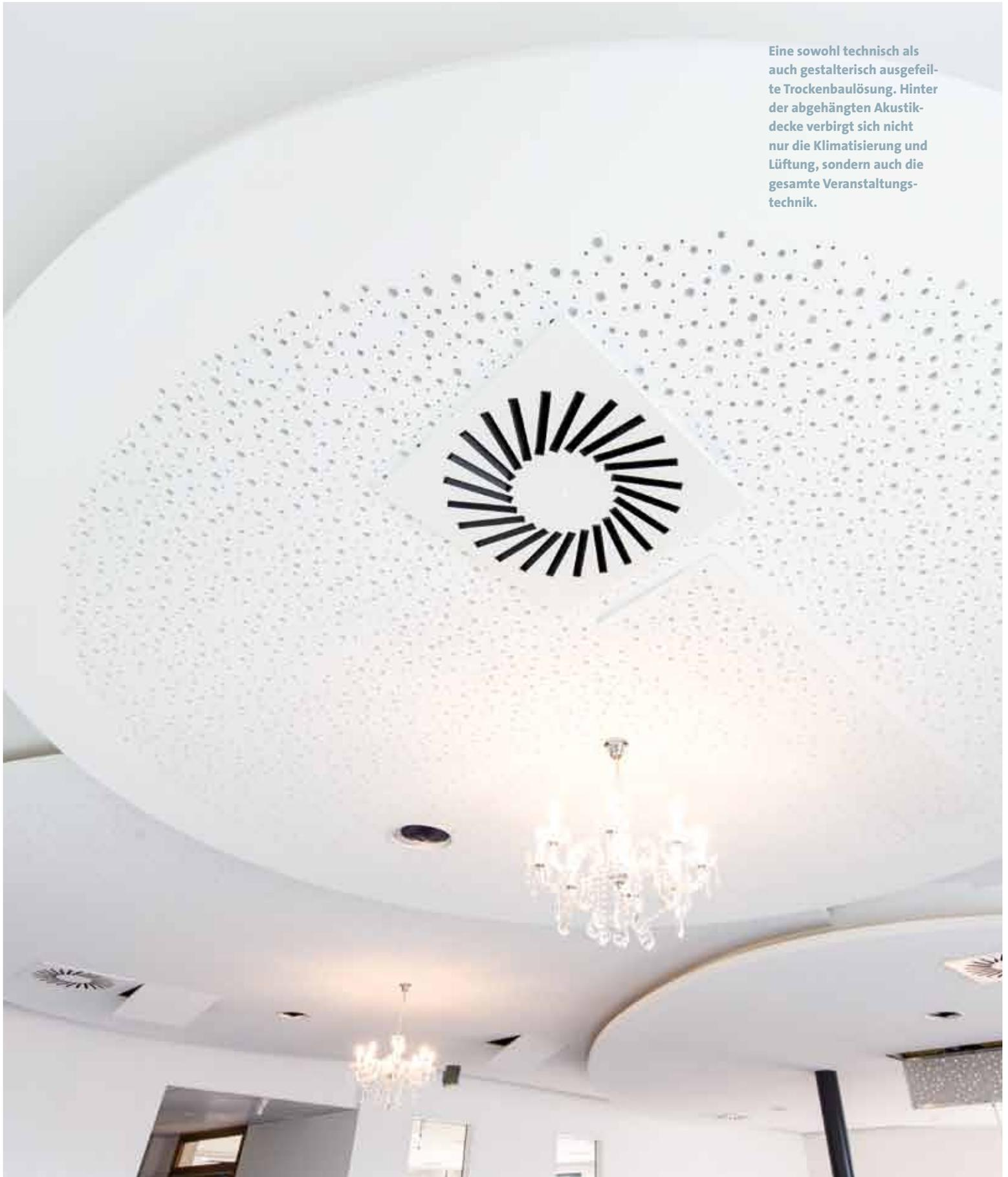
Eine sowohl technisch als auch gestalterisch ausgefeilte Trockenbaulösung. Hinter der abgehängten Akustikdecke verbirgt sich nicht nur die Klimatisierung und Lüftung, sondern auch die gesamte Veranstaltungstechnik.
