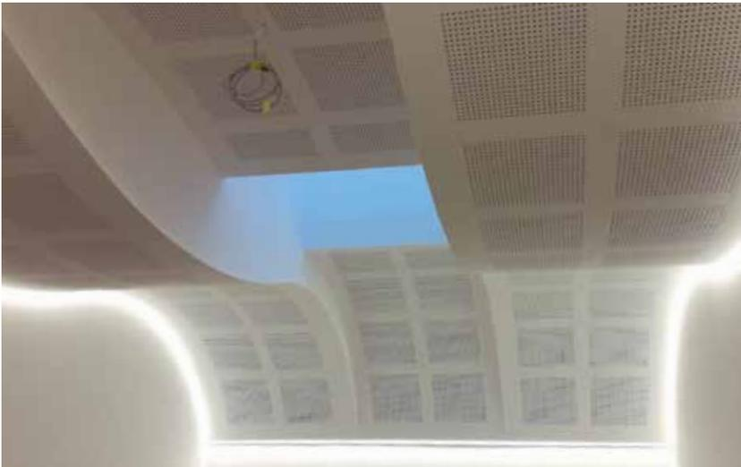
**Komplexe Unterkonstruktion: Der Deckenbereich über dem Stiegenaufgang wurde in drei Abschnitte mit unterschiedlich konvex und konkav gebogenen Segmenten geteilt.**
