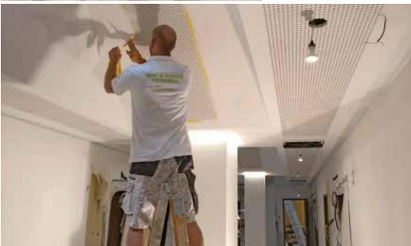
Beleuchtung wurde auch hier bereits mit der Unterkonstruktion verlegt und flächenbündig in die fertige Oberfläche eingearbeitet.
