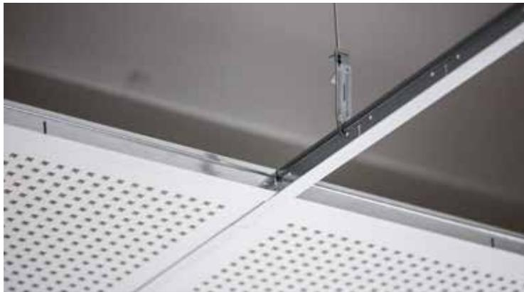
Die akustische Ertüchtigung erfolgte mit Gyptone Quattro 20 – eine Akustiklochplatte mit Quadratlochung auf Basis einer 10 Millimeter starken Gipsplatte mit einem rückseitig aufkaschierten Akustikvlies.
